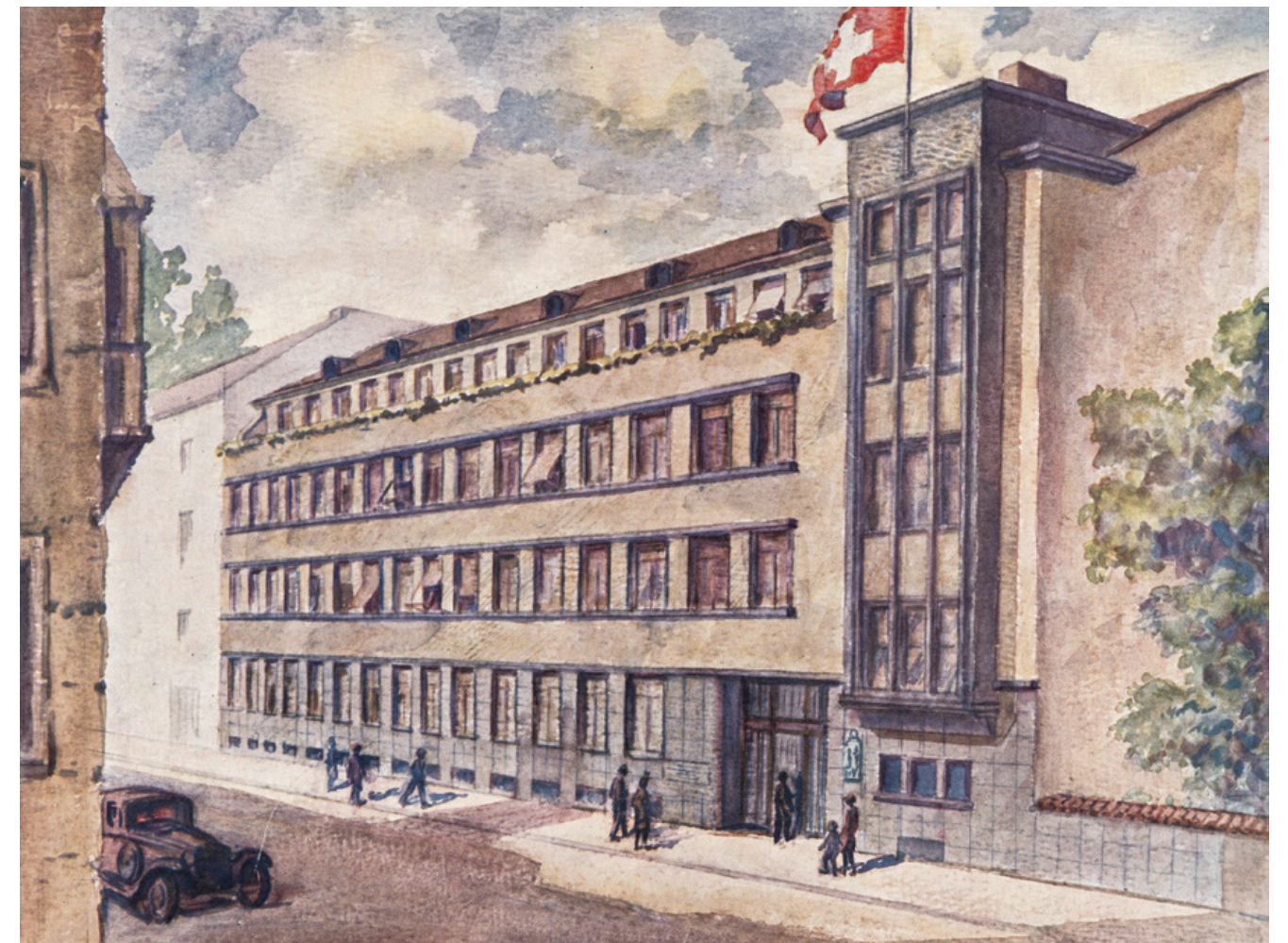
Das Verwaltungsgebäude der Schweizerischen Krankenkasse Helvetia wurde am 14. Juni 1942 eröffnet.
