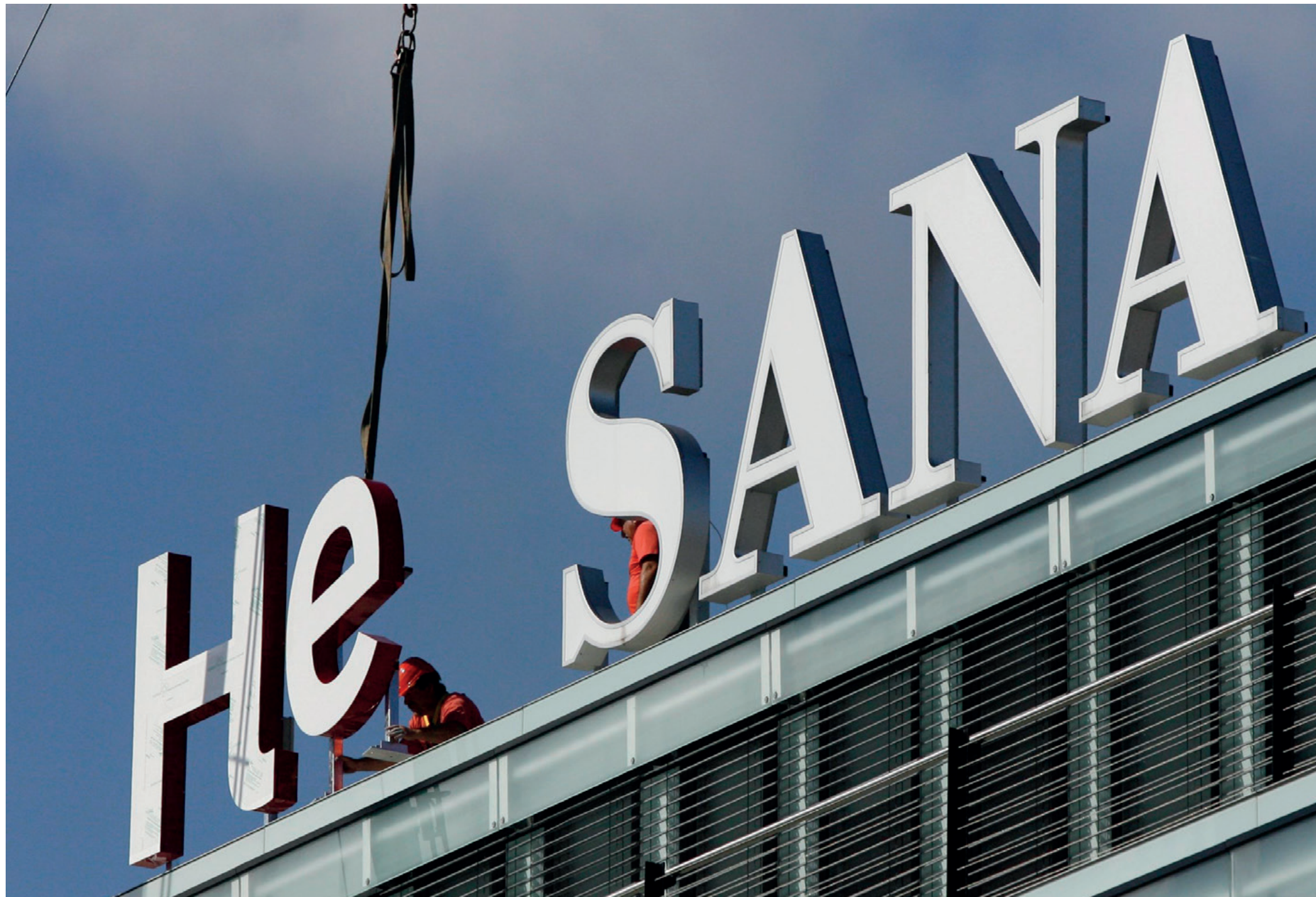
Alt und neu für einen kurzen Moment vereint: Die Montage des neuen Schriftzugs in Stettbach, September 2008.
